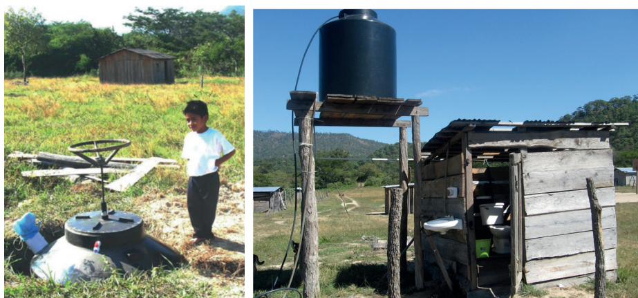
Figura 2. Dispositivo a escala real de una Letrina Ecológica con Biodigester integrado. El dispositivo fue probado en la comunidad Monte Horeb.
